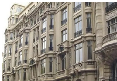
1 er immeuble en béton armé, rue Danton (75006), construit par et pour François Hennebique (arch. Édouard Arnaud) afin de prouver que ce nouveau procédé pouvait donner l'illusion des matériaux classiques.
