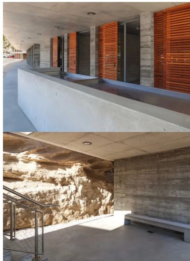
Le porte-à-faux de la dalle de l'esplanade vient créer une ombre protectrice sur les box et le banc de vente.
