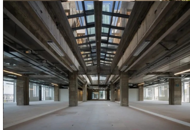
Au cœur de l'édifice, un patio triple hauteur, créé par la suppression de 4 000 m 2 de planchers, assure une réponse environnementale en termes de ventilation, de rafraîchissement, de désenfumage et de lumière naturelle.
