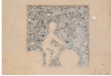
Les motifs ont été obtenus par sablage du béton recouvert de pochoirs créés par la plasticienne Sophie Balas.
