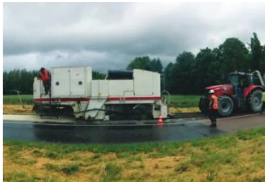
L'atelier de retraitement mobile à froid ARC 700 d'Eiffage, équipé du dispositif Recyclean®.
