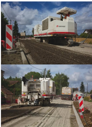
En milieu urbain, la présence de bordures, de tampons de voirie ou de bouches à clé n'empêche pas la mise en œuvre du retraitement en place. Solution choisie par Eiffage-Route sur ce chantier : les abaisser, avant de les relever.
