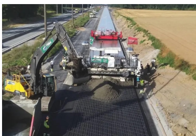
La nouvelle autoroute E42/A8 Kain-Lamain a nécessité la pose de 230 000 m 2 de BAC.
