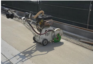
Des amorces de fissuration ont été réalisées par sciage au plus vite après le dénuçage. But : le développement rapide de fissures plus droites et régulières, réduisant le risque de regroupement.
