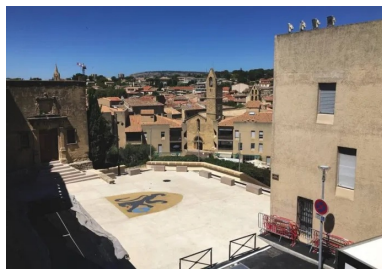
Le parvis rénové du château de l'Empéri accueille un nouveau dallage en béton bouchardé, spécialement étudié pour s'accorder aux remparts du château.
