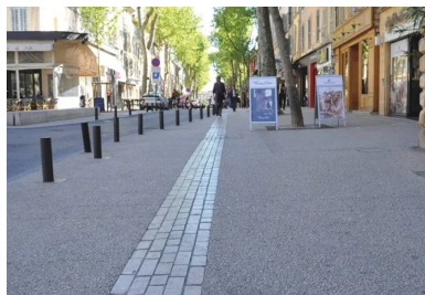
Le calepinage des bandes structurantes en pierre Cénia rythme les différents espaces (terrasses de café, fontaines) et les trottoirs qui ont été élargis.
