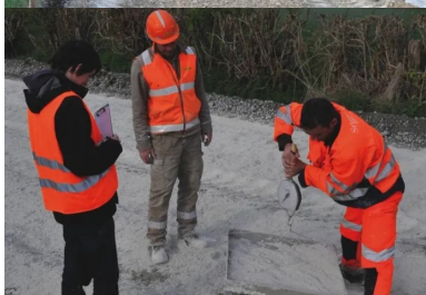
Véri cation de la quantité de liant hydraulique épandu par mètre carré, avec pesage d'un échantillon étalonné.
