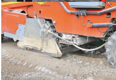
Le rotor du malaxeur mélange le matériau fragmenté de l'ancienne chaussée avec le liant Equiom ROC AS dosé à 4 %.
