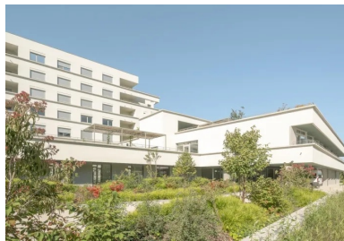
Une forte présence du végétal à tous les étages, y compris au niveau du parvis ouvert aux riverains.
