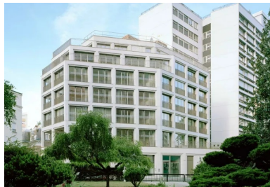
La Sirène en rez-de-chaussée et les six niveaux de logements sont adossés au pignon de l'immeuble Méridien.
