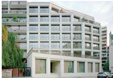
Les inflexions dans la volumétrie sont générées par le dialogue avec les bâtiments voisins.
