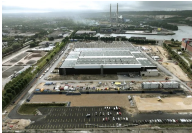
Futur centre de distribution clients d'Ikea à Limay. © Medinger & Fils
