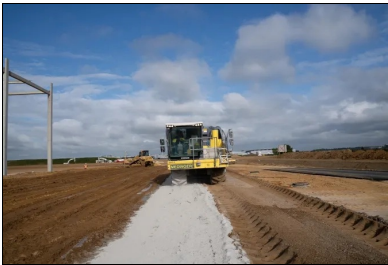
Le sol et le liant ROC AS sont mélangés à l'aide d'un pulvimalaxeur asservi Wirtgen. ©Medinger & Fils
