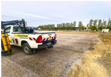
Contrôle à la dynaplaque de la portance de la CDF traitée. © Medinger & Fils
