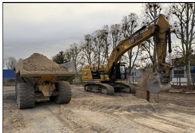
Extraction sur site des sols et acheminement pour la confection des CDF de la plateforme support. © Medinger & Fils
