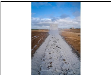
Épandage du liant ROC AS à l'aide d'un épandeur asservi. ©Medinger & Fils
