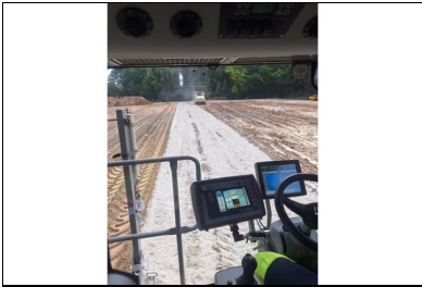
Vue du traitement depuis l'intérieur de la cabine du pulvimalaxeur. ©Medinger & Fils
