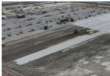
Phasage optimisé du chantier. À l'arrière-plan, la construction du bâtiment en cours. Au premier plan, la réalisation de la CDF traitée pour les voies et aménagements extérieurs. © Medinger & Fils
