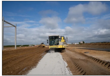
Le sol et le liant ROC AS sont mélangés à l'aide d'un pulvimalaxeur asservi Wirtgen. ©Medinger & Fils
