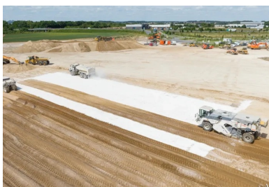
Entrepôt logistique Illies-Salomé, Hauts-de-France (59). Colas a réalisé une plateforme support de haute qualité PF3 en mettant en œuvre une couche de forme traitée au liant ROC VDS d'EQIOM (cf. Routes info #32). © Colas/SAGL
