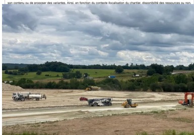
Aire de repos de La Grolle sur la RN10 (16). Ecostab a réalisé une plateforme support de haute qualité PF3 en améliorant la PST à la chaux et en confectionnant une couche de forme traitée au liant Ligex M4 (Bussac) de Heidelberg Materials (cf. Routes info #23/24). © D.Daguzan/ECOSTAB
