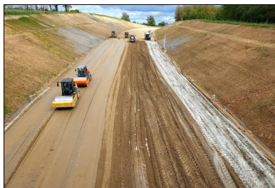
Déviations et mise à 2 x 2 voies de la RN141 entre Roumazières-Loubert et Exideuil-sur-Vienne (16). Guintoli/NGE a réalisé une plateforme support de haute qualité PF4 en renforçant la PST au liant Rolac Premier ECOPlanet et en confectionnant une couche de forme traitée au même liant Rolac Premier ECOPlanet de Lafarge (cf. Routes Info #39). © Guintoli/NGE
