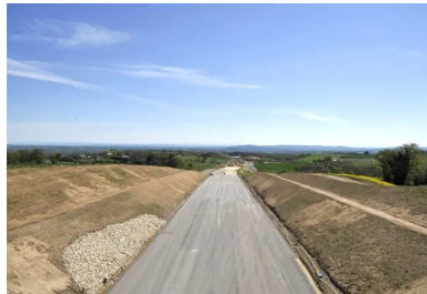
RN88 entre Baraqueville et La Mothe (aussi appelée « déviation de Baraqueville ») (12). Cazal TP a réalisé une plateforme de haute qualité PF3 en renforçant la PST au liant Rolac Optimum et en confectionnant une couche de forme traitée au même liant Rolac Optimum de Lafarge (cf. Routes info #19). © Fenêtre sur cour
