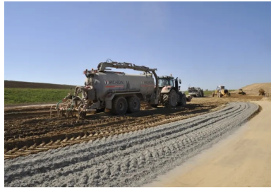
A355, contournement ouest de Strasbourg (67). Vinci Construction Terrassement Grands Projets a réalisé une plateforme support de haute qualité FF4 en améliorant la PST inférieure à la chaux et la PST supérieure au liant ROC COS et en mettant en œuvre une couche de forme traitée au même liant ROC COS d'EQIOM (cf. Routes info #16). © Fenêtre sur cour
