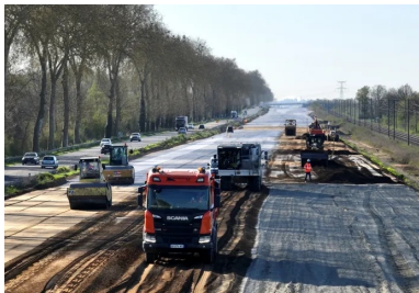
Mise à 2 x 2 voies de la RN7 dans la Nièvre (58). Roger Martin a réalisé une plateforme support de haute qualité PF4 en traitant la PST au liant LV-TS 03 et en confectionnant une couche de forme traitée au même liant LV-TS 03 de Vicat (cf. Routes info #41). © Roger Martin
