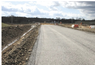
ZAC d'Ozans, Indre (44). Le groupement Sétéc (mandataire et pilote) / Eurovia a réalisé une plateforme support de haute qualité PF3 en mettant en œuvre une couche de forme traitée au liant LV-TS 03 de Vicat (cf. Routes n° 125). ©Cimbéton
