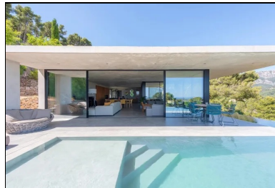
Le mur ouest et la dalle de la toiture enveloppent les lieux de la vie commune de leur parement en béton brut.
