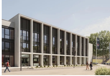
Avec leurs hauts poteaux assemblés de 4 et 10 m, les portiques en béton brut préfabriqués caractérisent la façade nord et rythment l'allée des Lions.
