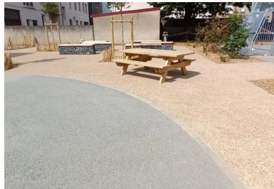
Bétons drainant et désactivé à Thionville. ©EQIOM
