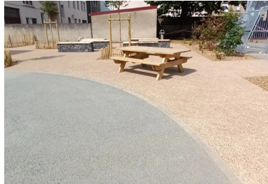
Bétons drainant et désactivé à Thionville. ©EQIOM
