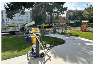
Aspirateur utilisé lors du ponçage du béton. ©Efcac
