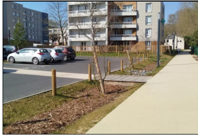
Quartier après travaux à Laval, exemple de végétalisation. ©Plaine Etude
