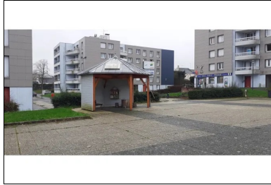
Quartier avant travaux à Laval. ©Plaine Étude
