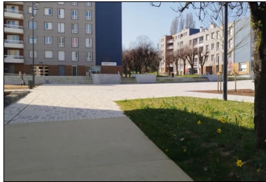
Quartier après travaux à Laval, exemple d'intégration de pavés en béton. ©Plaine Etude
