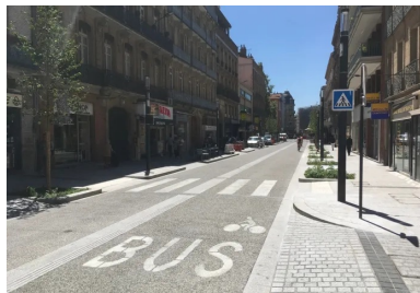
À Toulouse, béton désactivé clair résistant aux charges lourdes canalisées sous forte chaleur. © Groupe Sols
