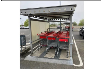
Poinçonnement de caddies de supermarché et solution composite « métal-dalles en béton ». ©Cédric Le Gouil
