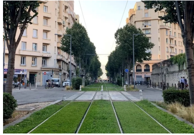
Tramway à Marseille. Couplé à une trame verte, le béton « invisible » apporte toujours ses qualités structurantes et durables. © Carrières et Bétons Bronzo Perasso
