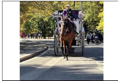
Orniérage du matériau bitumineux à Central Park, à New York. © Damien Meyer
