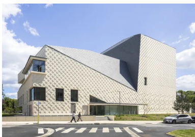
Abaissé au maximum, le volume contenant l'auditorium semble s'enchaîner dans celui contenant la cage de scène.
