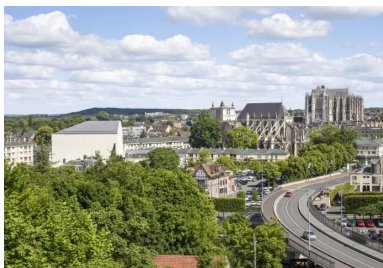
Depuis le plateau sud, le théâtre s'affiche comme le troisième monument de grande hauteur dans la ville.
