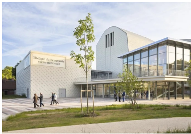
Les volumes fonctionnels s'identifient clairement dès le parvis d'accueil public et arboré.
