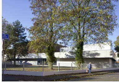
Les volumes des deux salles de sport forment un tout repérable grâce au bandeau béton qui fédère l'ensemble.
