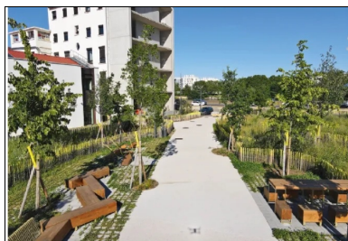
Ph 8. Aménagement piétonnier en béton sablé avec granulats recyclés - Champ Nord Confluence, à Lyon 2. Ciment utilisé : CEM IV/A. © BASE
