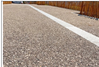
Ph 6. Aménagements piétonniers (BC3) et bus à haut niveau de service (BC5) en béton désactivé à Marseille. Liant utilisé : (CEM I + laitier), équivalent en composition à un CEM II/B-S. © CARRIERE ET BETONS BRONZO PERASSO
