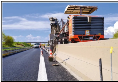
Ph 11. Réalisation de 20 km de séparateur béton sur l'autoroute A28, barrière de Saint-Christophe-sur-le-Nais (37). Ciment utilisé : CEM III/B. © AXIMUM
