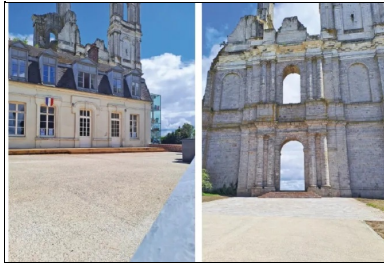
Ph 12. Aménagement du parvis des vestiges de l'abbaye de Mont-Saint-Éloi (62) en béton désactivé. Ciment utilisé : CEM III/C. © SÉBASTIEN CARON/EQIOM
