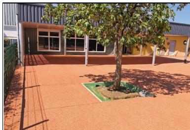
Ph 7. Aménagement et désimperméabilisation d'une école maternelle en béton drainant coloré à Saint-Martin-d'Auxigny (18). Liant utilisé : (CEM II/A + laitier), équivalent en composition à un CEM II/B-S. © GUILLAUME MERLE
