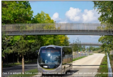
Structure en béton désactivée sur voie ou arrêt de bus et plateforme en site propre - Résistance aux efforts de freinage et au trafic canalisé sans déformation. © VINCENT VIDAL
