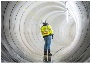
Le collecteur de 620 m de long, creusé sous la Seine à 25 m de profondeur, assure l'acheminement des effluents vers le bassin.
