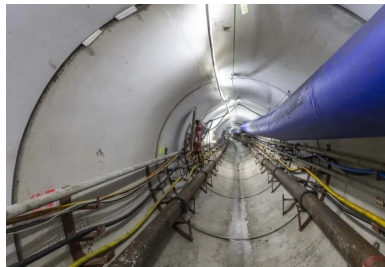
Le tunnel collecteur est constitué de 310 tuyaux en béton armé préfabriqués, résistants à la pression et aux agressions chimiques.
