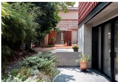
Le soubassement en béton banché se prolonge en terrasse à la manière d'un patio.
