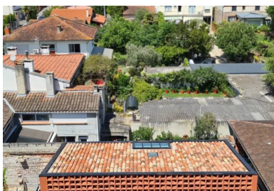
Calée en fond de parcelle en retrait de la rue, la maison Cob est exclusivement orientée sud-est.
