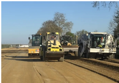
Vue d'un atelier de traitement des matériaux en place au liant LV-TS 03. (©Joseph Abdo/JA-Consulting)
