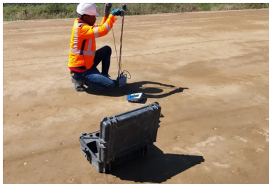
Contrôle de compactage au pénétromètre dynamique léger à énergie variable Panda. (©Joseph Abdo/JA-Consulting)
