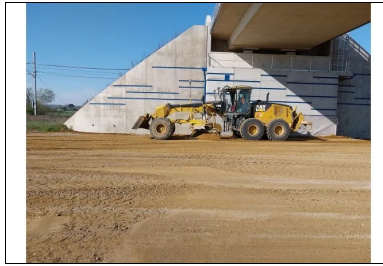
La couche de forme en matériaux B4/B5 prête à recevoir les opérations de traitement. (© Roger Martin)
