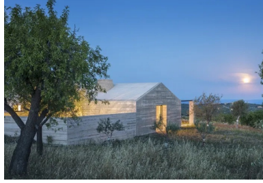
Implantée dans la pente du terrain, la Casa Bendico, enveloppée de sa double coque en béton banché, se fond dans le paysage.
