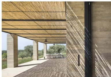
Protégée par une tonnelle légère reposant sur des piliers massifs, une profonde pergola étend les pièces de vie sur toute la longueur de la façade sud-est.
