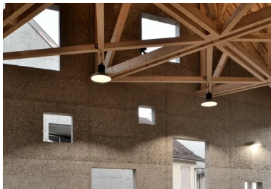
La halle résulte de l'association de deux matériaux bruts : un socle maçonné supportant une charpente en épicea massif.
