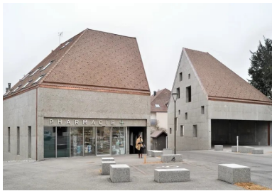
Bordant la place et tenant lieu de porte d'entrée, les deux nouvelles constructions forment un tout que l'on aurait scindé en deux.
