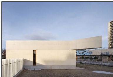
Avec poésie le bâtiment réinterprète des éléments du contexte. Le dessin de la gargouille reprend la ligne fuyante du viaduc du métro.
