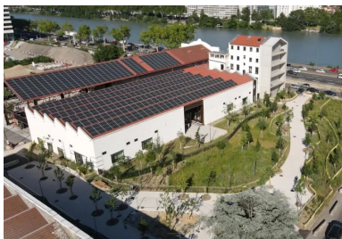
Petit Champ. 9 000 m 2 de cheminements principaux sont réalisés en béton recyclé à empreinte carbone réduite. (© Agence Base)
