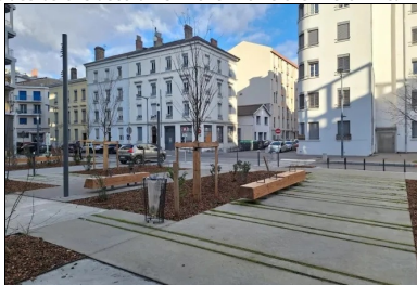
Aménagement de la place du Marché en béton micro-désactivé. (© Detrez, Sols)
