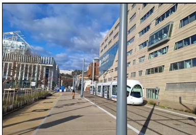
Aménagement en béton micro-désactivé du trottoir et du revêtement de la plate-forme de tramway. (© Detrez, Sols)
