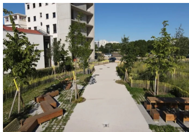
Petit Champ. Les premiers bétons 100 % recyclés et à empreinte carbone réduite (sur base de pouzzolane) ont été réalisés en 2019 (en finition sablée). (© Agence Base)
