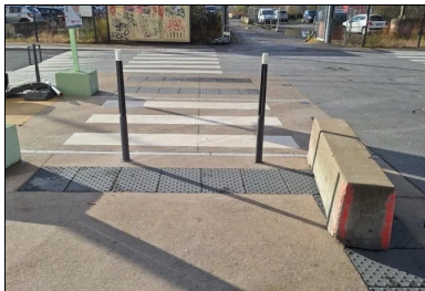
Aménagement d'un plateau surélevé en béton micro-désactivé. (© Detrez, Sols)
