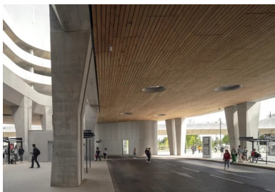
L'espace de la gare est totalement dégagé grâce à l'intégration de tous les équipements techniques.
