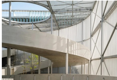
Le pavillon d'accès est protégé par une façade ajourée en lames d'aluminium posées verticalement.
