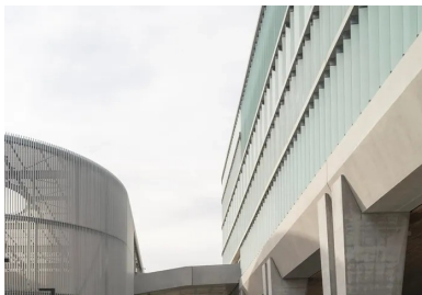
Un pavillon autonome, abritant une rampe d'accès voitures, marque l'entrée dans le parking, accessible après la traversée d'une passerelle suspendue.
