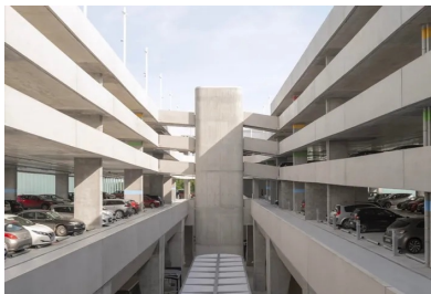
Le plan du bâtiment, structuré autour d'un vide central, favorise l'aération des parkings et diffuse la lumière naturelle jusque dans les moindres recoins.
