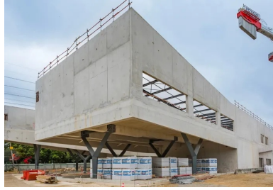
Gare d'Antony-pôle-Wissous, Ateliers 2/3/4/ architectes, photo : © Olivier Brunet
