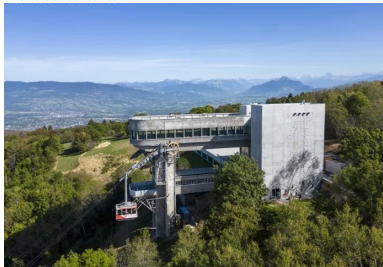
Façade ouest. Le haut mur d'escalade comme la tour-escalier qu'il dissimule sont réalisés en béton préfabriqué.
