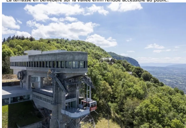
Preuve de la gare haute dont l'implantation des piliers correspond au franchissement d'une zone calcaire instable.
