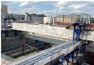
Des portiques de levage situés de part et d'autre de la méga-poutre permettent de descendre celle-ci jusqu'à sa position définitive, par l'intermédiaire de chevêtres brülés à la structure par des barres précontraintes.
