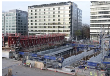
Vue globale montrant l'aire de préfabrication des méga-poutres (poutre coffrée, bandes rouges).
