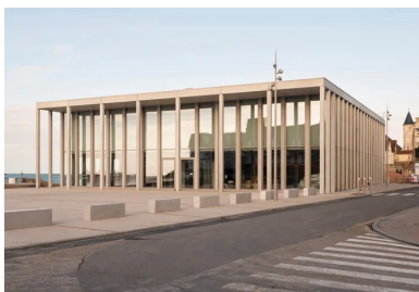
La position centrale de l'exosquelette de béton définit les deux espaces publics du grand parvis en béton sablé coulé sable micro-désactivé et du jardin qui longe la cale à l'arrière.
