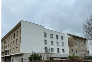
Chantier de l'ensemble EPHAD Pacy-sur-Eure [1] (DR Heidelberg Materials)
