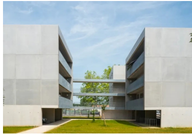
Dominant des gazons aux découpes géométriques, l'architecture oscille entre composition orthogonale et nuances des surfaces en béton.
