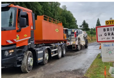
État de la RD119 avant les travaux. (©Colas)
