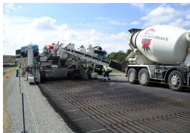
Chaussée composite BAC/GB3.
