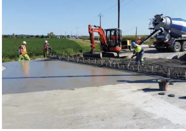
Mise en œuvre du béton à la poutre vibrante.
