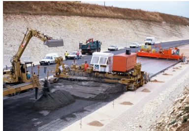
RN 141. Déviation des Rassats-Favrauds- Mise en œuvre de la chaussée composite en BAC/GB3 en 1998. Cette structure assure parfaitement son rôle aujourd'hui sans avoir fait l'objet d'entretien structurel (cf. interview Gilles Lacassy, DIRA).
