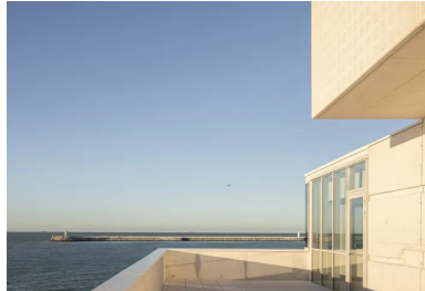
Le dessus des murs de terrasse intègre un léger creux dans le béton de manière à éviter l'ombre et le débord de la couverture sur la façade.
