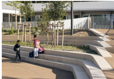
Un aménagement en gradins qui permet de gérer la pente naturelle du terrain anime la cour.
