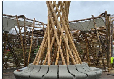
Piédestal central - bambou et impression béton 3D - du Pavillon éphémère de la Fédération de Surf pour les JO Paris 2024, conçu et réalisé par l'ENA de Montpellier-La Réunion
