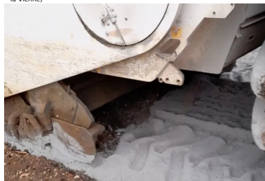
Malaxage du matériau de l'ancienne chaussée avec le liant Ligex M10 sur une profondeur de 35 cm à l'aide d'un pulvimixeur moderne Wirtgen WR240i, permettant d'obtenir un matériau homogène sur toute l'épaisseur et sur toute la largeur de la nouvelle chaussée. (©Ludovic Padeloup/Conseil départemental de la Vienne)
