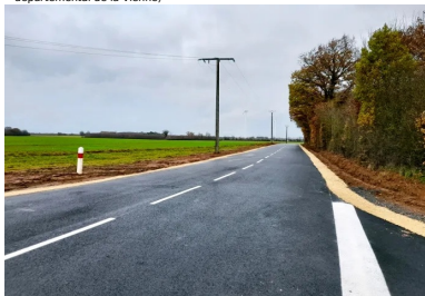
Le tronçon rénové de la RD7 a reçu un nouveau tapis d'enrobés (EB10 sur 6 cm d'épaisseur), avant d'être rouvert à la circulation le 16 décembre 2022. (©Ludovic Padeloup/Conseil départemental de la Vienne)
