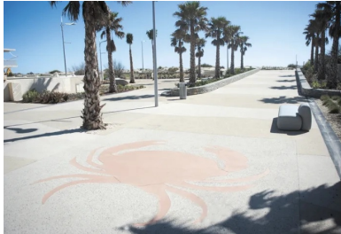
Aménagement en béton imprimé, en béton incrusté et en béton désactivé.
