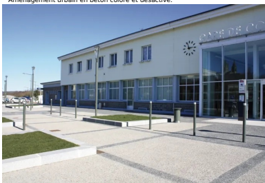
Parvis de gare en béton désactivé.
