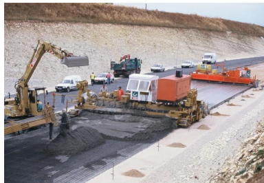
Mise en œuvre à la machine à coffrages glissants d'une structure composite en Béton Armé Continu BAC sur Grave Bitume GB3. RN 141 ; Déviation des Rassats-Favraults.
