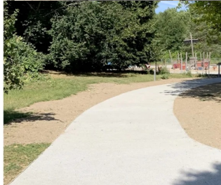
Allée en béton drainant - Au fond Aire de jeux en béton drainant.
