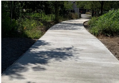
Allée en béton recyclé (100%).
