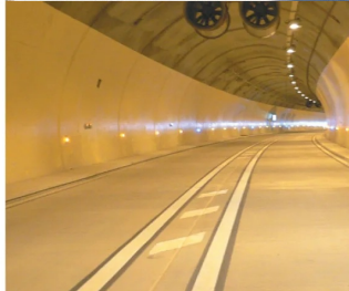
Tunnel en béton.
