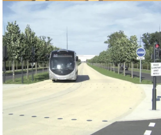
Plate-forme de Bus à Haut Niveau de Service, Melun - Sénart.
