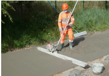
Mise en œuvre du béton manuellement.
