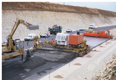
Mise en œuvre à la machine à coffrages glissants d'une structure composite en Béton Armé Continu BAC sur Grave Bitume GB3. RN 141 ; Déviation des Rassats-Favrauds.
