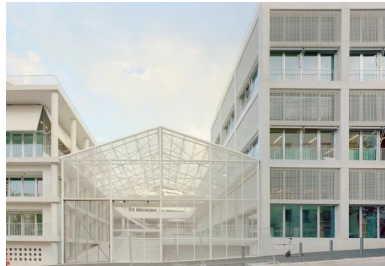
La cour d'expérimentation en partie protégée par une serre possède un accès direct sur la rue Nédélec.
