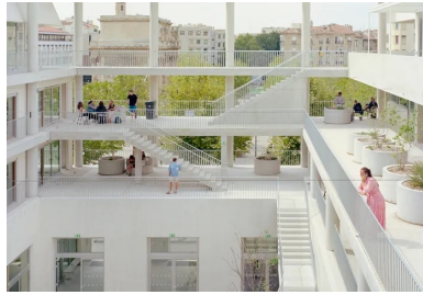
Dans le prolongement de la place de la porte d'Aix, la cour d'accueil regroupe autour d'elle, au rez-de-chaussée, l'espace d'exposition « le Forum », la cafétéria et les amphithéâtres.
