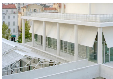
Les panneaux inclinés en béton blanc, qui protègent du soleil l'enveloppe vitrée de la bibliothèque, signalent sa présence dans le pôle commun.
