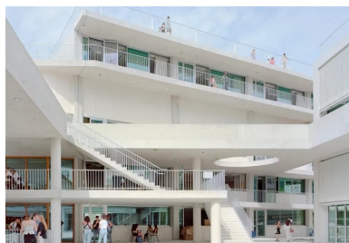
Tous les prolongements extérieurs constituent comme une superposition de sols qui irriguent l'édifice et facilitent les relations transversales entre les corps de bâtiment et les différents niveaux.
