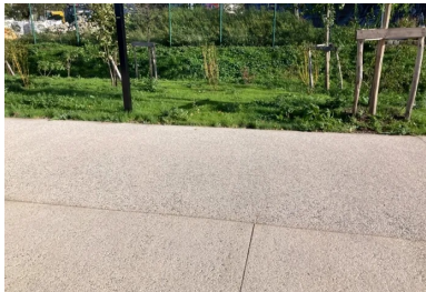
Sciage du joint de retrait longitudinal sur toute la hauteur du revêtement et des joints de retrait transversaux en quinconce. (©Joseph Abdo/JA-Consulting)
