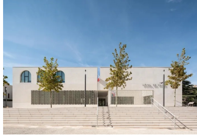
Entrée principale à droite de laquelle on aperçoit, à travers le claustra, la cour des mariages.
