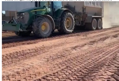
Épandage du liant avec précision à l'aide d'un épandeur tracté Streamaster. (© SARL Alan Brunner)
