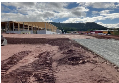
Vue générale du projet d'extension, avec au premier plan la plate-forme des aménagements extérieurs en cours de traitement au liant LV-TS 54. (© Scierie-Gaiffe et Avinim Construction)
