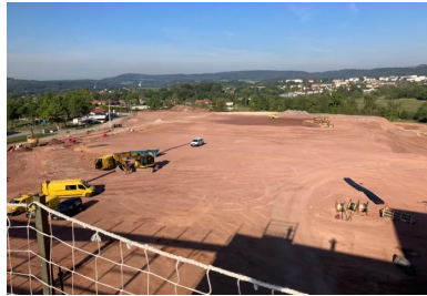
Vue générale du chantier de terrassement. (© Scierie-Gaiffe et Avinim Construction)
