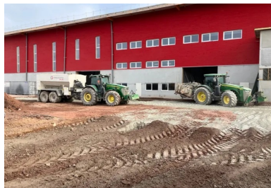
Atelier de traitement. Epandeur tracté Streamaster (à gauche) et Malaxeur tracté Wirtgen W5 250 (à droite). (© Scierie-Gaiffe et Avinim Construction)
