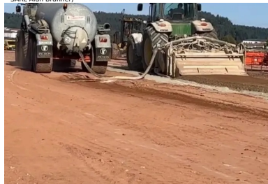
Le malaxeur tracté Wirtgen W5 250 mélange intimement le sol, le liant et l'eau introduite directement dans la cloche du malaxeur (© SARL Alan Brunner)
