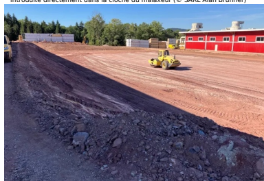
Compactage du sol traité. (© Scierie-Gaiffe et Avinim Construction)
