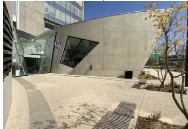
Les deux façades convexes en béton orientent les flux du public vers le volume de l'entrée en verre collé.
