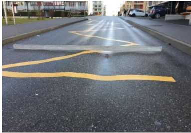
Photo 3 : arrêt de bus déformé - (c) CIMBETON
