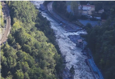
À Fontan, les brèches n° 19 et n° 20 sur la RD 6204, emportée sur 150 ml.
