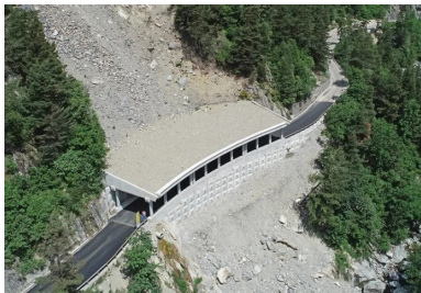
Paravalanche RD 91. La galerie paravalanche combine des éléments préfabriqués et du béton coulé en place.
